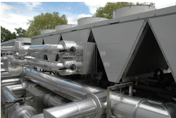
Figuur 6: Warmteterugwinning op de condensor van de koelmachine
