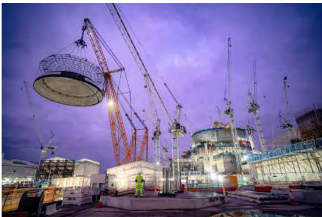
Met behulp van 's werelds grootste kraan, Big Carl, wordt een stalen koepel van 245 ton op het eerste reactorgebouw in aanbouw van Hinkley Point C gehesen. © Ben Birchall / Getty Images
