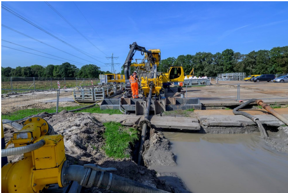
Figuur 2.12 Aanleg van een kabelverbinding door middel van een gestuurde (HDD) boring (bron: TenneT)
