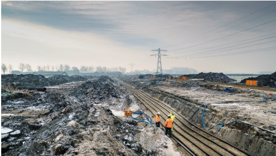
Figuur 2.11 Aanleg van een kabelverbinding in open ontgraving (bron: TenneT)
