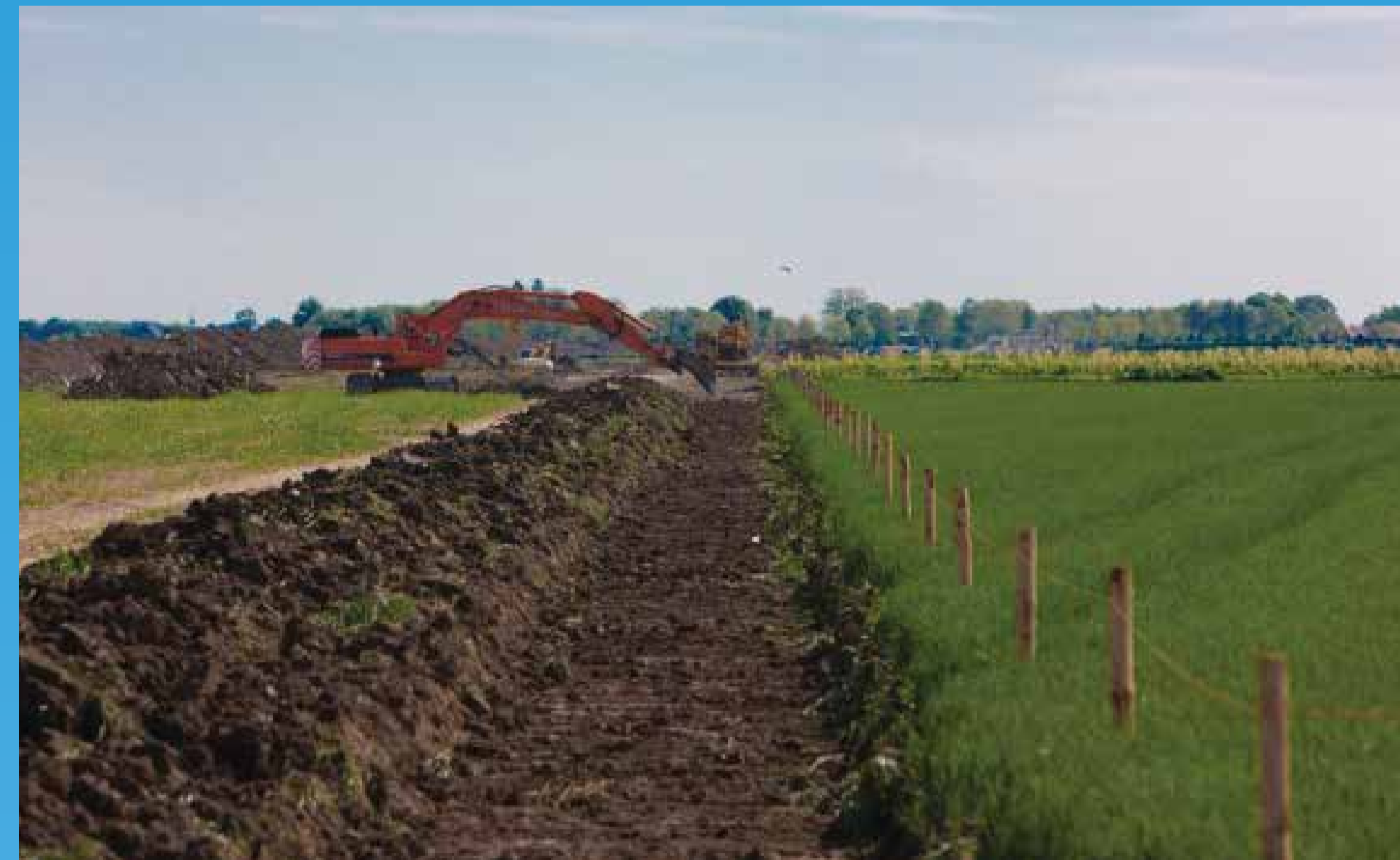
Het graven van de sleuf voor de buisleiding.
