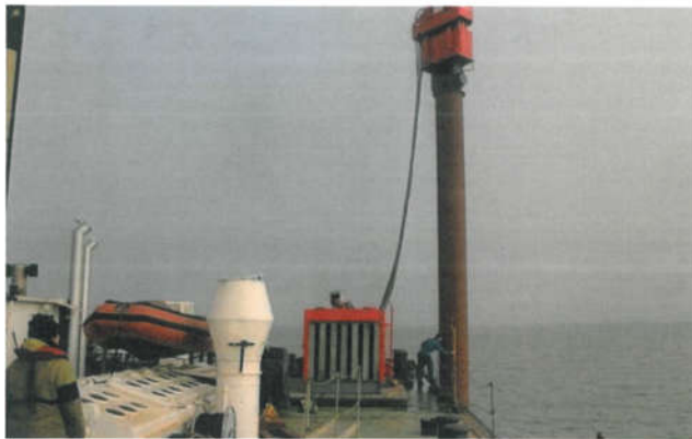
Figuur 4: intrillen van een paalanker
