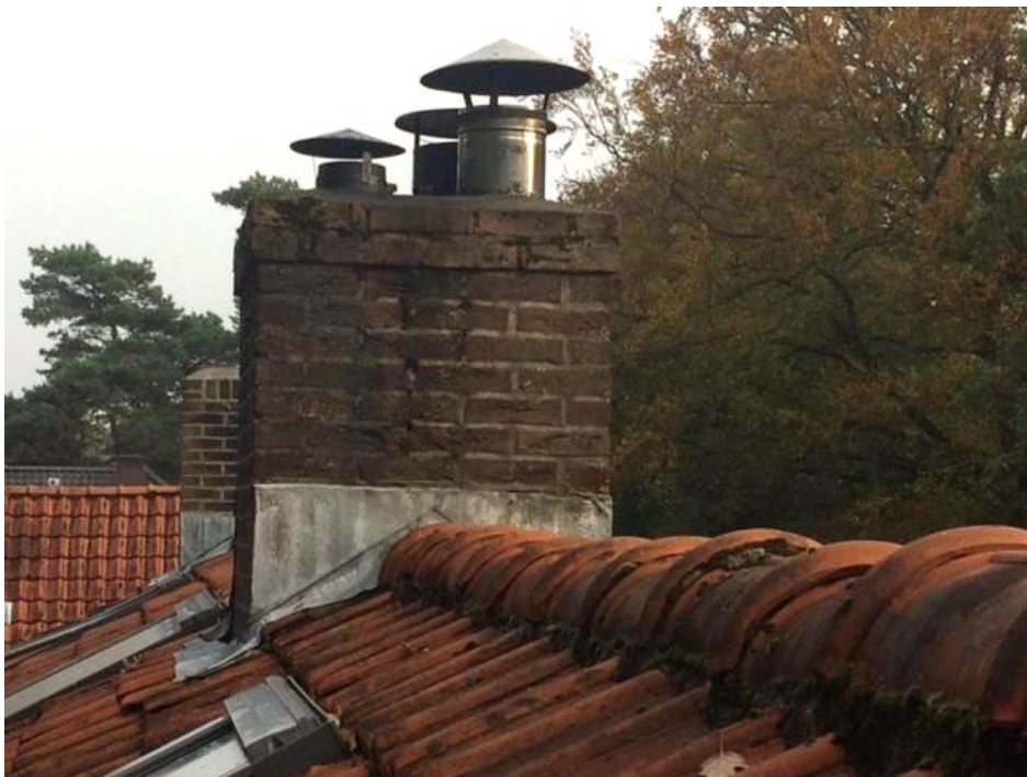
Voorbeeld schoorsteen met loodslab (Bron: Werkspot.nl)
