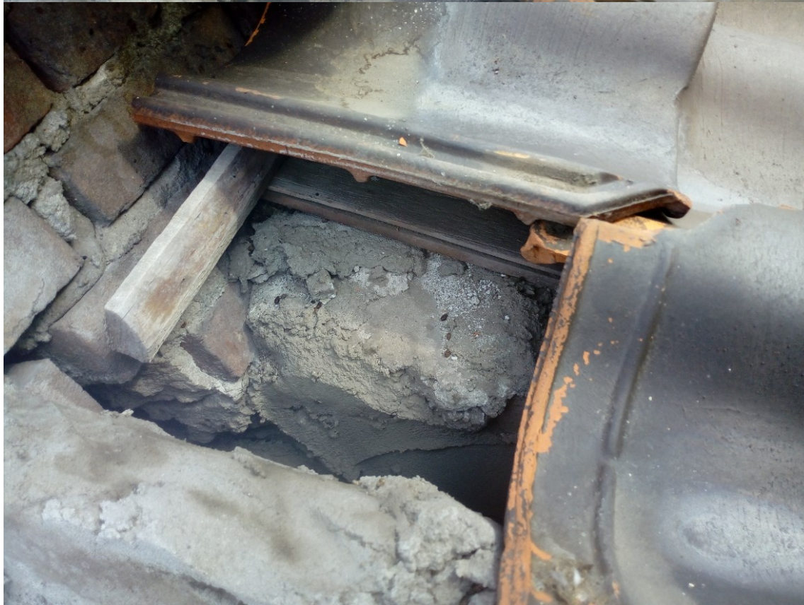
Laatvliegerverblijf met toegang via loodslab bij schoorsteen naar verblijf onder dakpannen (hele dak) en/of spouw met keutels op regelwerk en specie met verblijf. Project van St Joseph in Boxtel (Bron: Arcadis)
