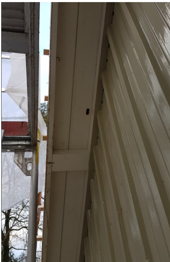
Schematische weergave vleermuisverblijf in dakoverstek in combinatie met gierzwaluwvoorzieningen en een vleermuisverblijf achter gewelbetimmering. De foto's hebben betrekking op het gierzwaluwverblijf (maatwerk kasten) (Bron: Arcadis)
