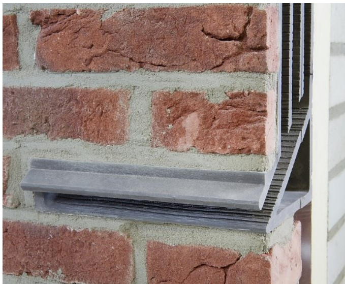
Ingebouwd Tichelaar prefab verblijf. Voorbeeld geschikt als kraamverblijfplaat (Bron: Koninklijke Tichelaar Makkum)
