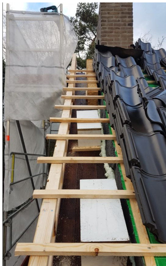
Schematische weergave vleermuisverblijf in dakoverstek in combinatie met gierzwaluwvoorzieningen en een vleermuisverblijf achter gewelbetimmering. De foto's hebben betrekking op het gierzwaluwverblijf (maatwerk kasten) (Bron: Arcadis)
