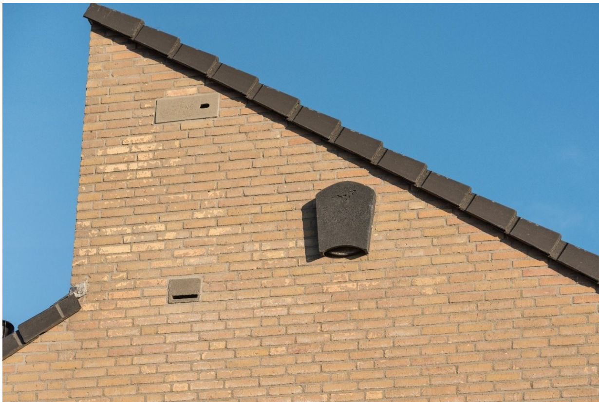
Entreesteen ingebouwd (links onder) in combinatie met een inbouwkast gierzwaluw en een opbouw vleermuiskast (tijdelijke mitigatie) (Bron: Vivara Pro)
