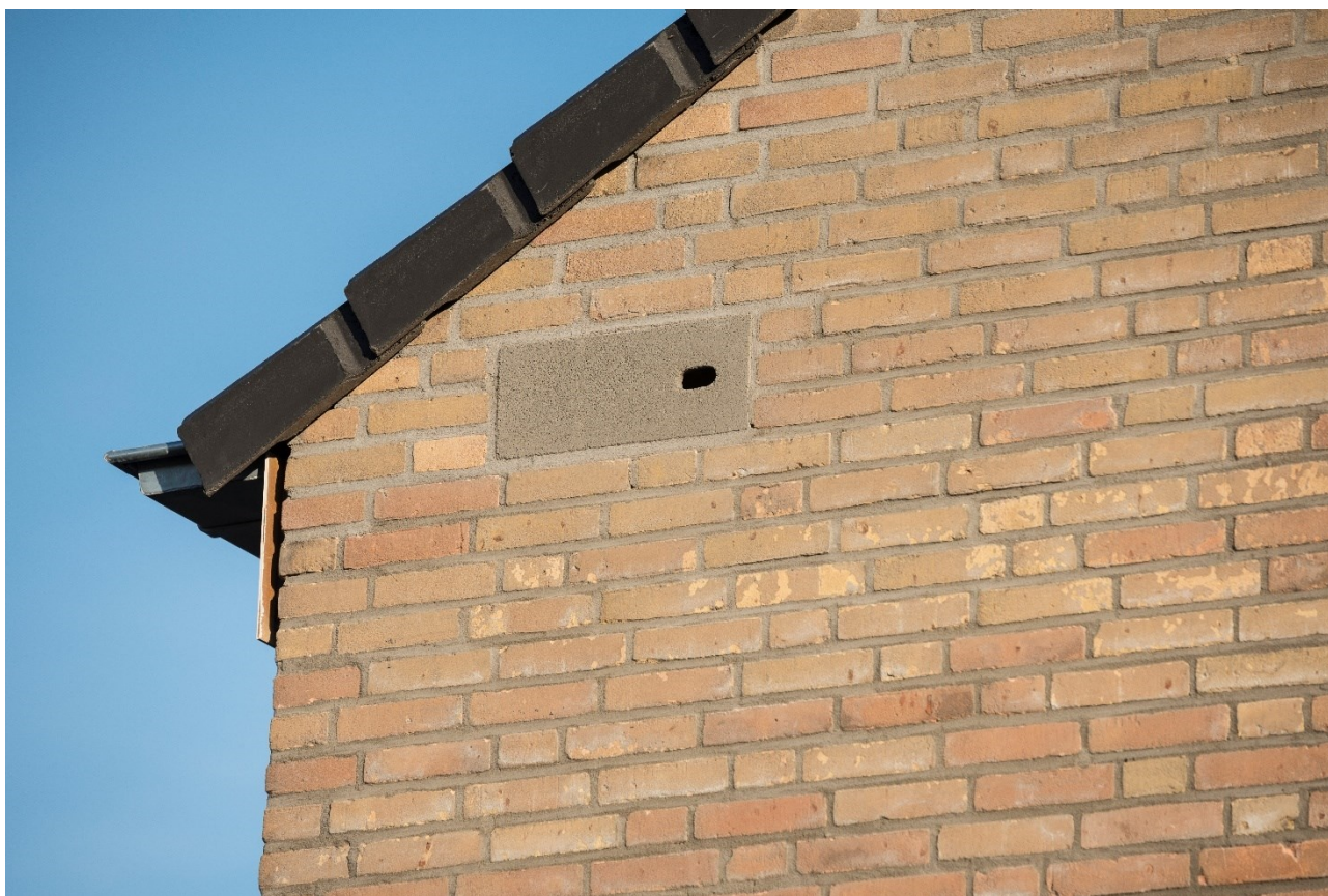
Inbouwkast van gierzwaluw verwerkt in de kopgevel van een woning (Bron: Vivara Pro)
