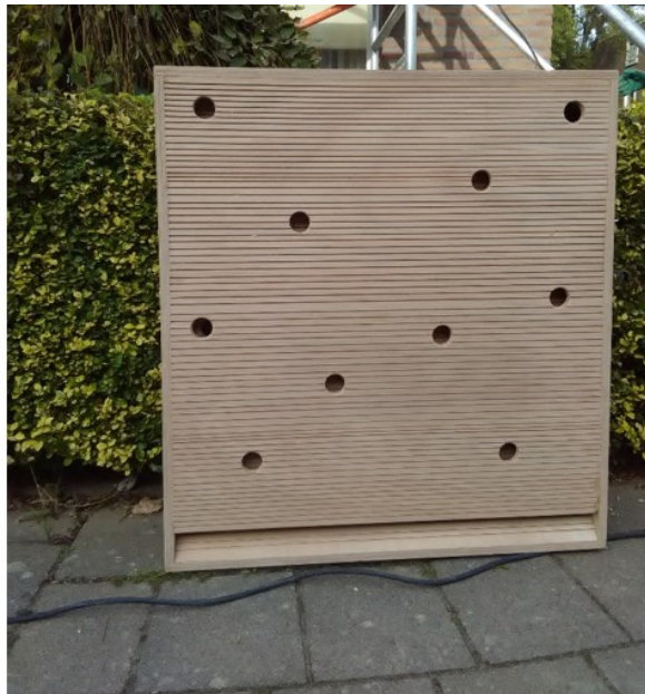
Vleermuisverblijf en -kast achter houten betimmering, Pancerstraat Maastricht, Servatius. Bovenstaande tekening betreft het ontwerp en onderstaande foto's de uitvoering. Let hierbij op dat dit verblijf voor gewone dwergvleermuis is gemaakt en de openingen in de latten vrij smal. Voor grotere soorten zoals laatvlieger dient dit groter te zijn (20-30 mm). (Bron: Arcadis)
