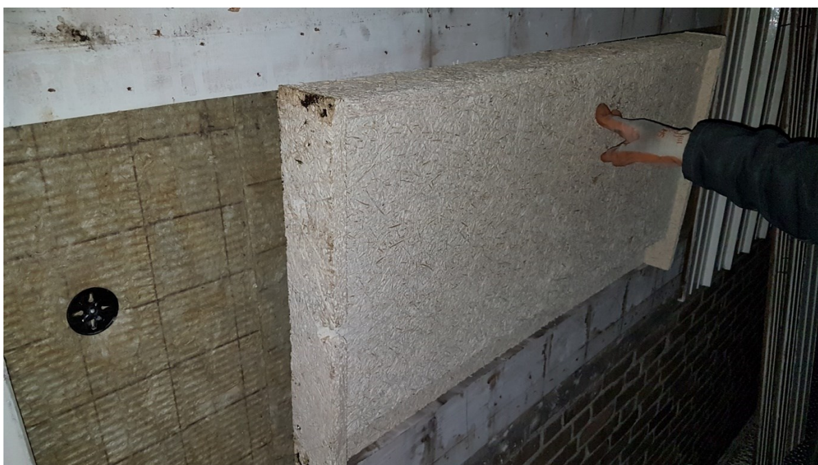
Vleermuisverblijf achter houten betimmering gecombineerd met een op maat gemaakte inbouwkast welke vanachter de gevelbeplating toegankelijk was voor vleermuizen, Breekkers te Son, Woonbedrijf Eindhoven. (Bron: Arcadis)
