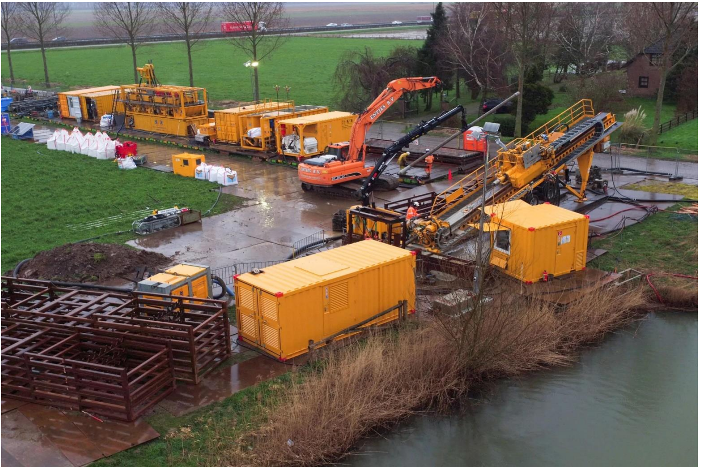
Figuur 3-7 Boorstelling (rig) voor de uitvoering van een horizontaal gestuurde boring.
