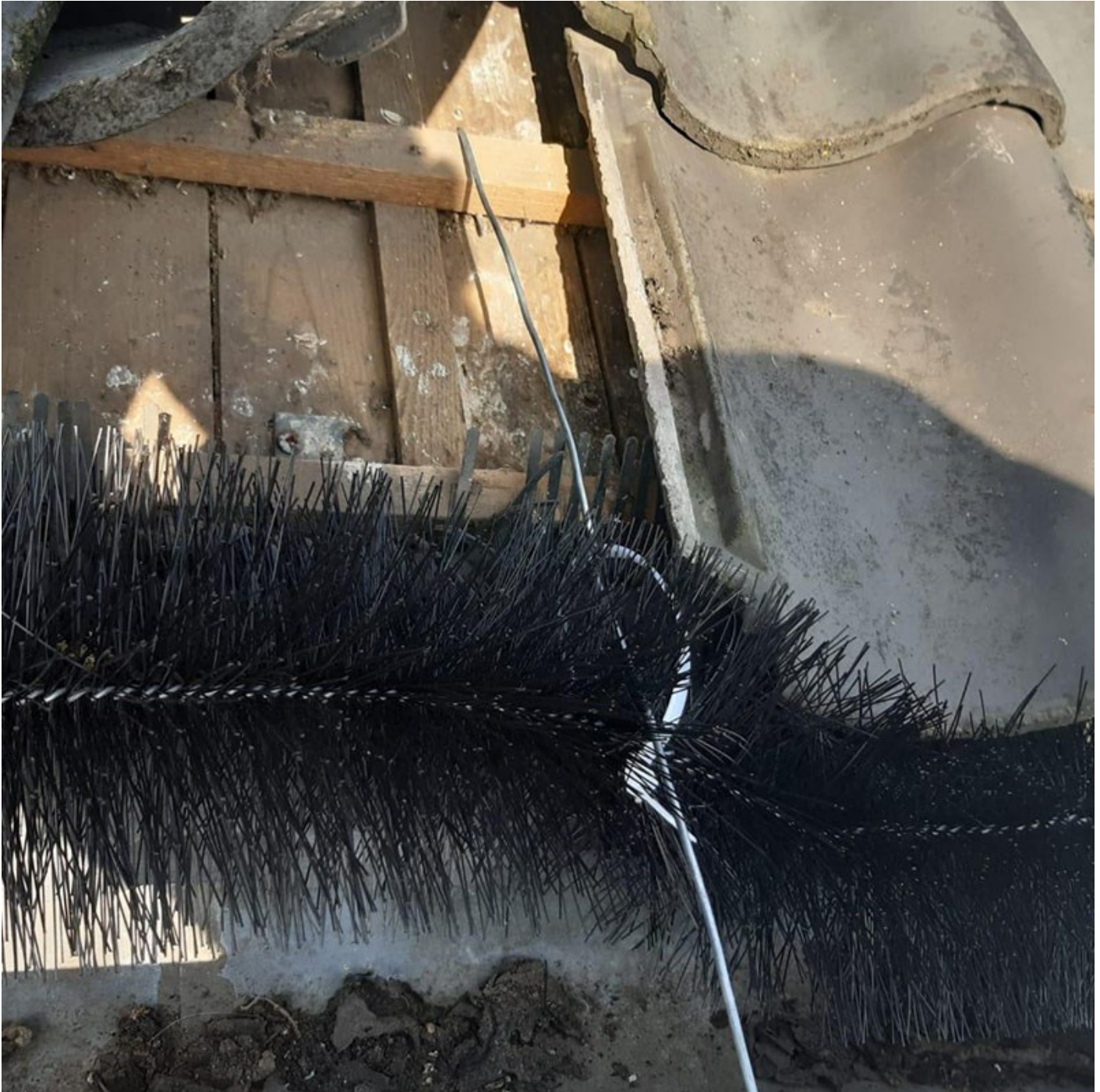
Figuur 7 Spouwborstel vastgezet met borstelhaak (Bron: Unitura.nl)
