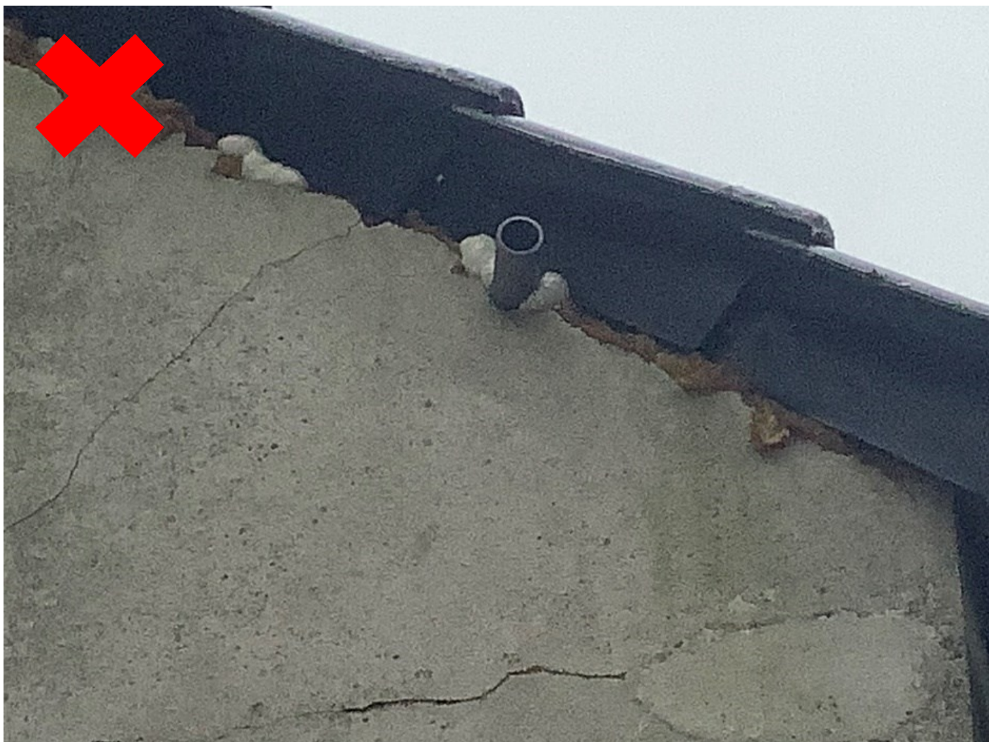
Figuur 5 Foutieve 'exclusion flap' (het pijpje)
