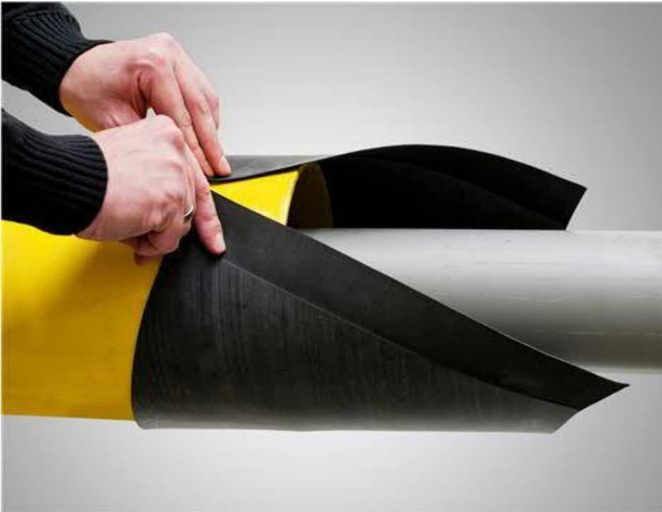
Figuur 12 Installatie afsluitmanchet
