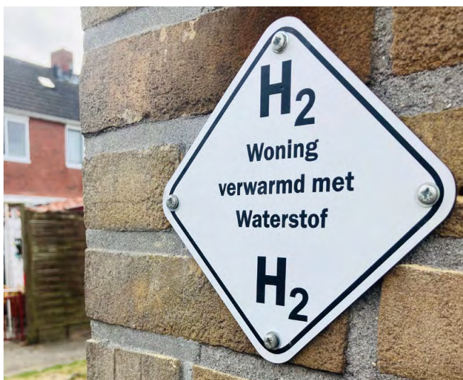
Naast de voordeur van iedere waterstofwoning hangt een bordje zodat eventuele aannemers of installateurs ook later geïnformeerd zijn.
