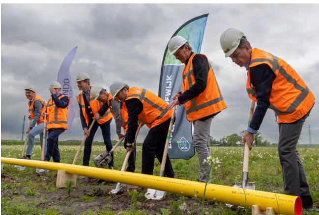
Tussen het invoestation en het distributienet in de wijk Erflanden (Hoogeveen) is een nieuwe 4-bar gasleiding aangelegd.
