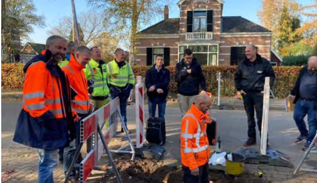
In Lochem wordt waterstof gedistribueerd via bestaande gasleidingen. Voor aardgas is een nieuwe leiding aangelegd, aan de andere kant van de straat.
