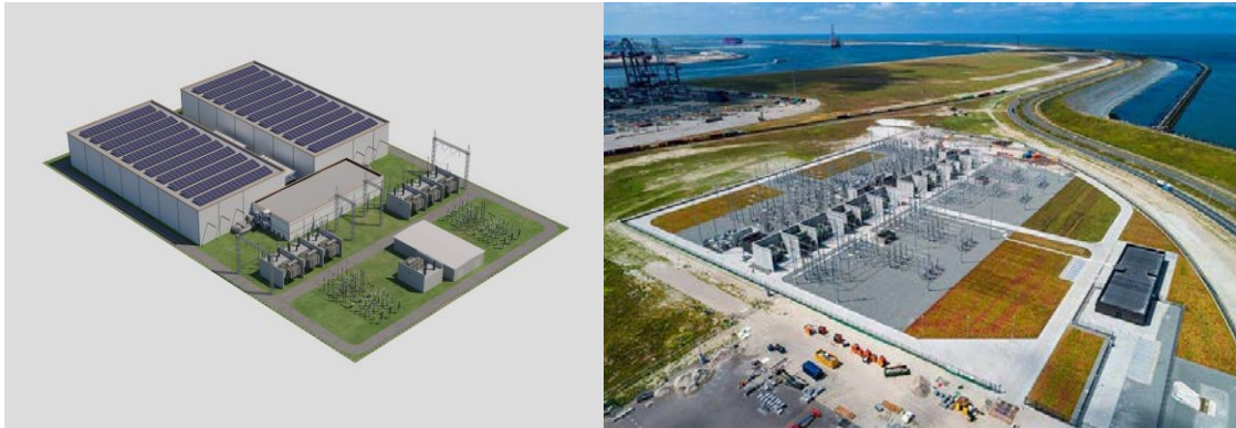
Afbeelding 3.6 Converterstation (links) en transformatorstation (rechts).
