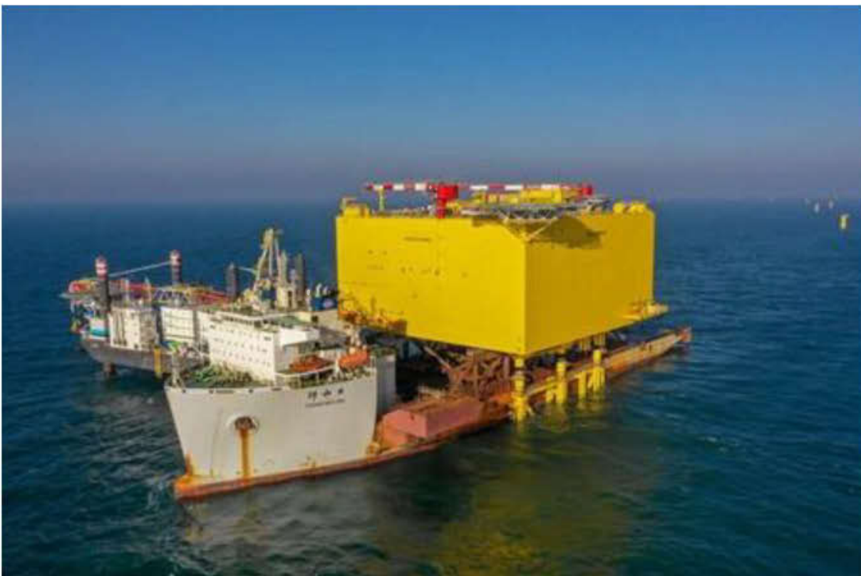
Figuur 3-5 Impressie drijvende installatietechniek
