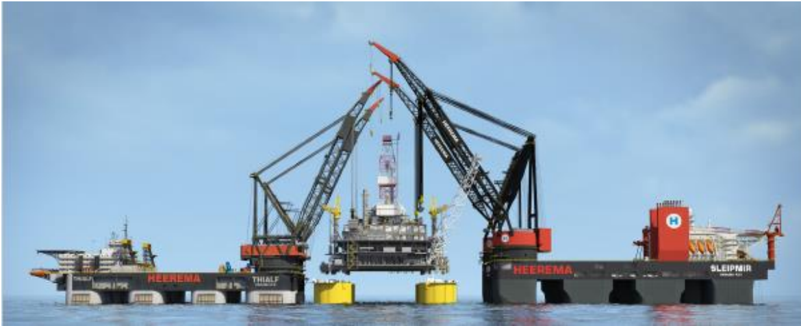
Figuur 1-5 Bovenbouw ophijzen met behulp van twee kraanschepen (hier: "Sleipnir" en "Thialf")
