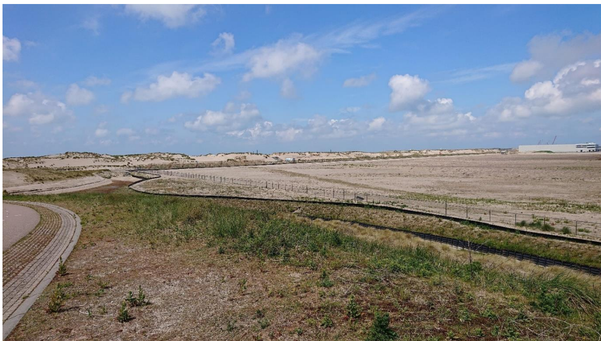
Figuur 3-6 De converterstationslocatie van Net op zee Nederwiek 2 (vanaf zuidoostelijke kant gefotografeerd)
