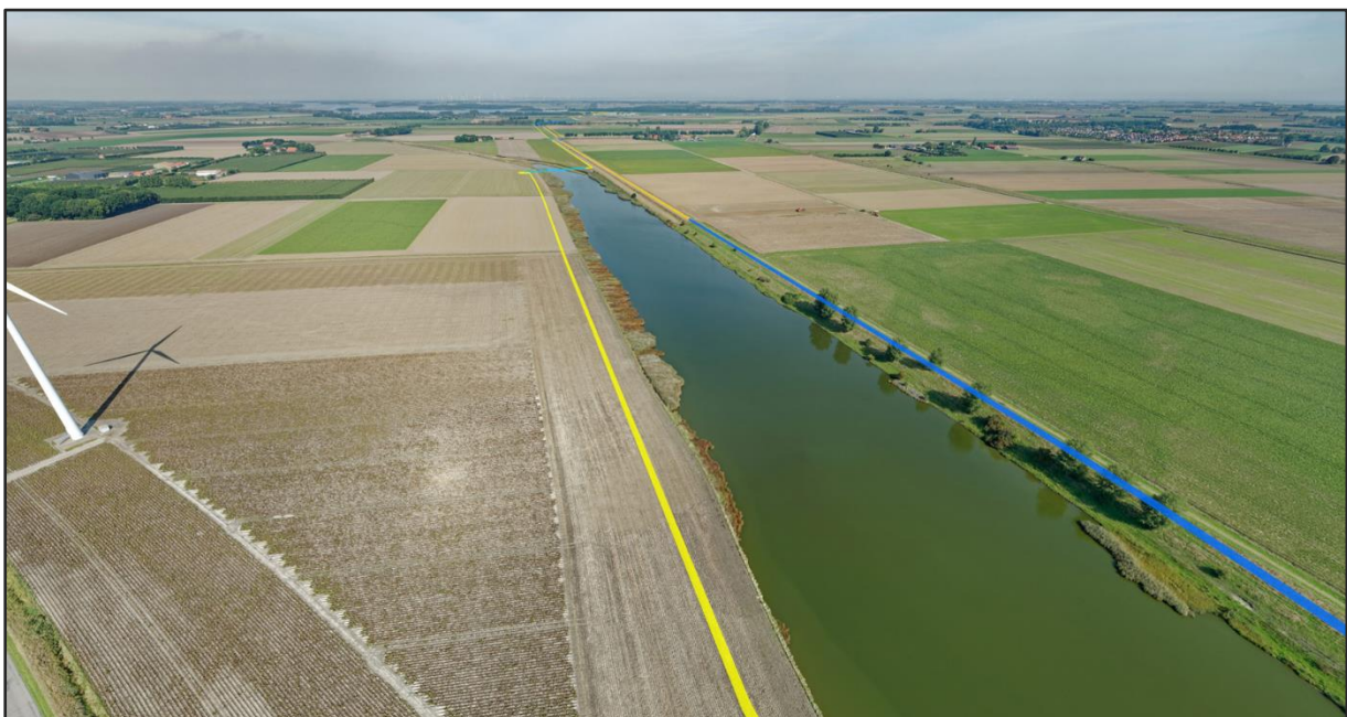
Figuur 3-7 Route kabeltracé bij Sloekreek (Geel = kabeltracé Net op zee IJmuiden Ver Alpha, blauw = kabeltracé Net op zee Nederwiek 1)
