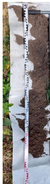
Profielboring in de berm tussen bomen 12 en 13 op de rand van de kroonprojectie: De toplaag van 0-110 cm bestaat uit uiterst fijn, droog zand met goede beworteling. Vanaf 110 tot 120 cm is klei aanwezig met alleen enkele fijne wortels. De zone tussen 120 en 130 met klei is sterk verdicht, licht vochtig en er zijn gley verschijnselen zichtbaar. De beworteling is hier zeer extensief.
