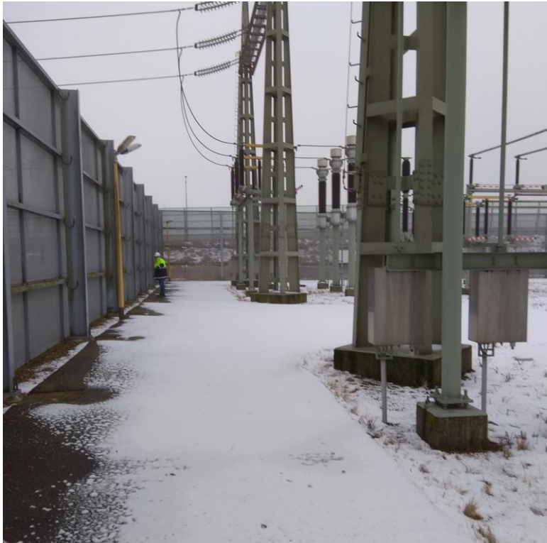
Figuur 16 bestaande situatie nabij hekwerk
