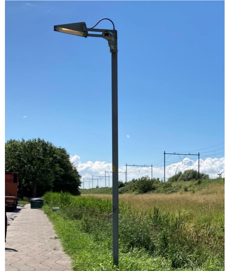
Lichtmast aansluitend bij bestaande lichtmasten
