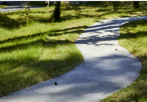
Geborsteld beton voor paden en ondergrond picknicksets
