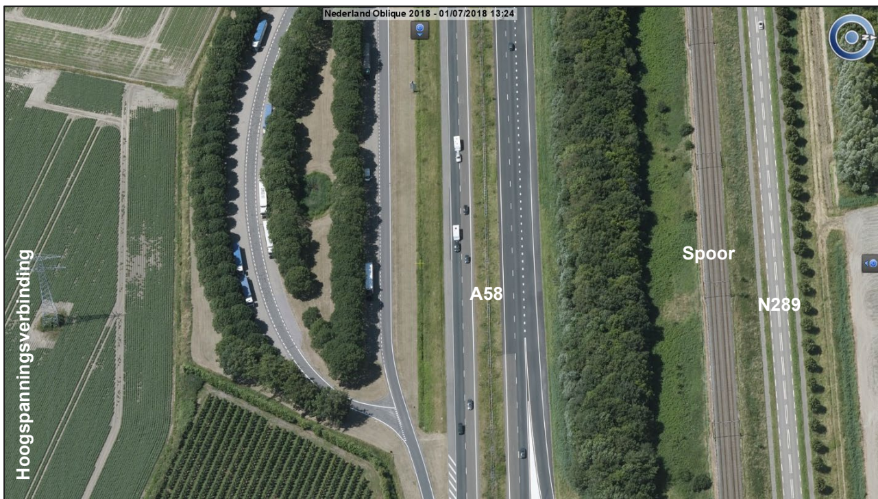
Figuur 22. Oblique luchtfoto van een deel van deelverbinding 1 ter hoogte van verzorgingsplaats 't Rak gezien vanaf het oosten, met daarop de huidige hoogspanningsverbinding, de A58, de spoorverbinding en de N289 (bron luchtfoto: Cyclomedia).
