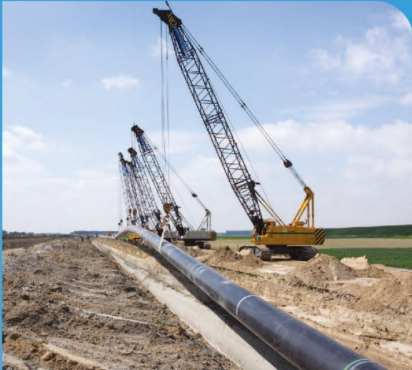
Aanleg leiding met open ontgraving
