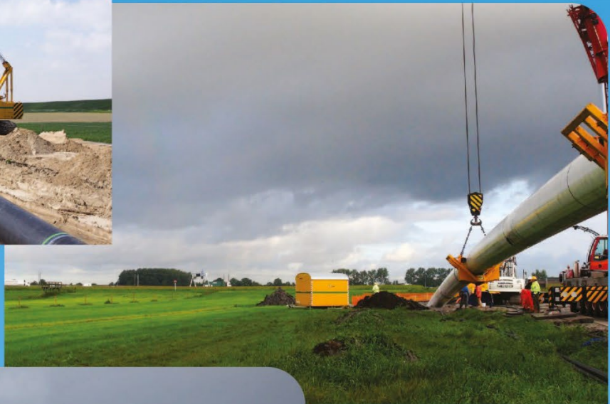
Aanleg leiding met horizontaal gestuurde boring
