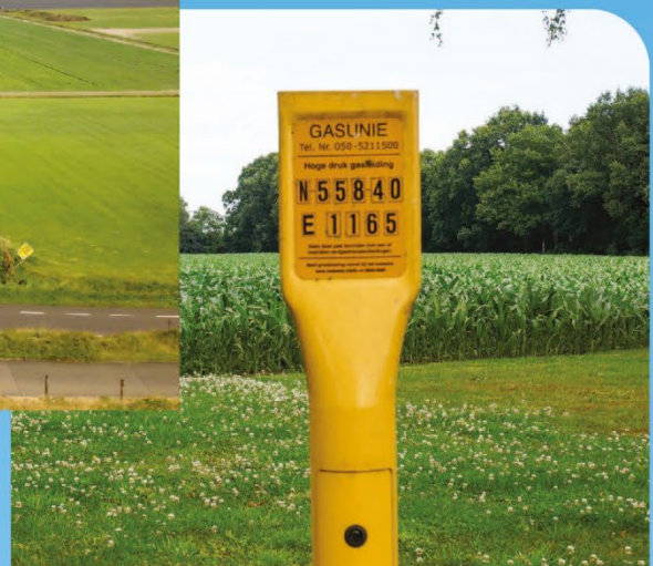
Gasunie-paaltje in landschap na aanleg leiding
