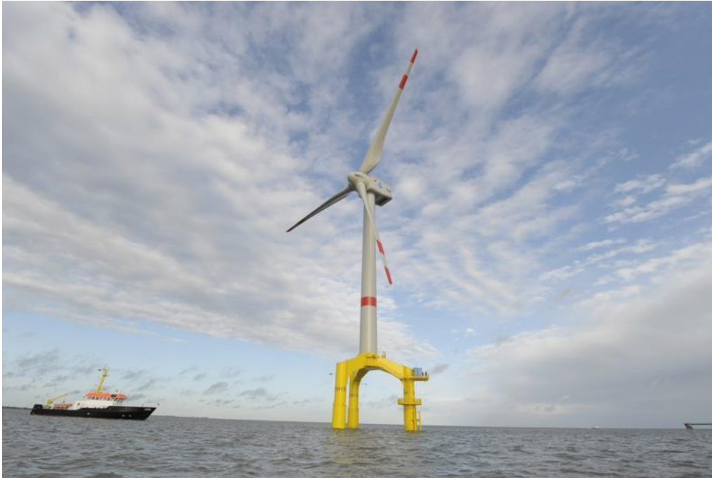
Figuur 2.3 Voorbeeld van een tripile fundatie 2 .
