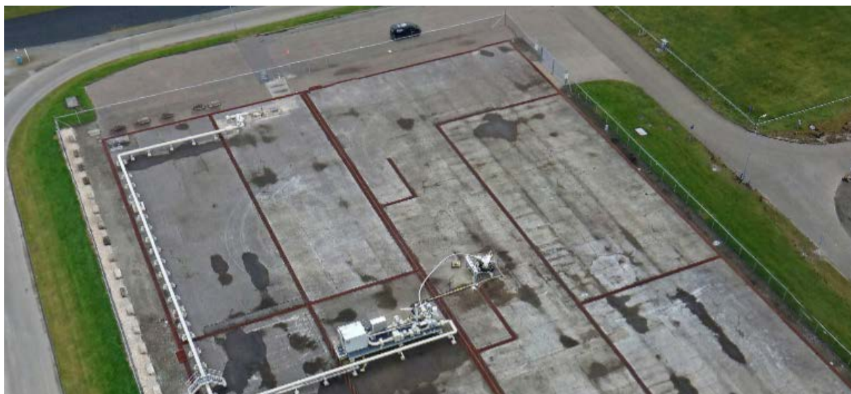
Voorbeeld van een gasproductielocatie met een gasproductieput en productie-eenheid.
