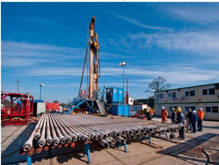
Figuur 3-4: Boormast bij proefboring naar zout.
