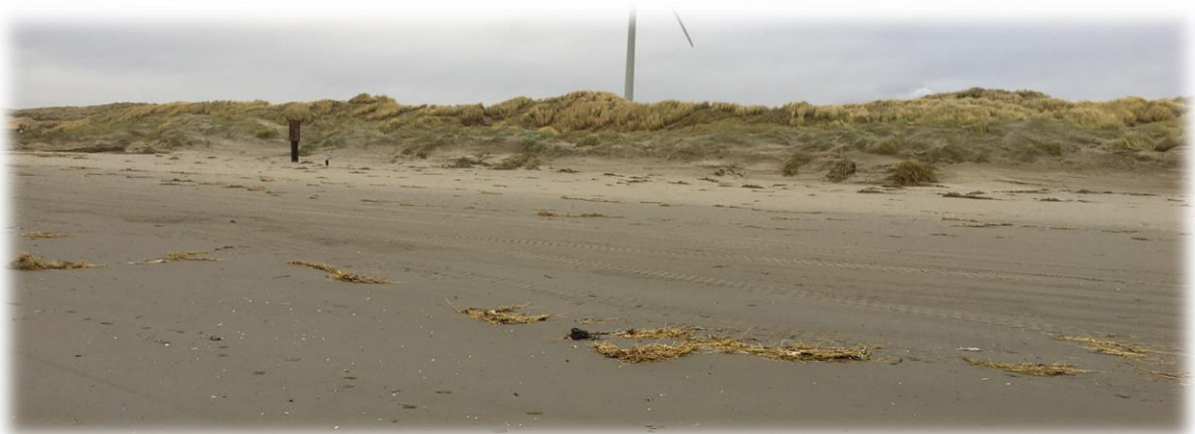
Afbeelding 24: Stormschade locatie HKwB na passeren Eunice
