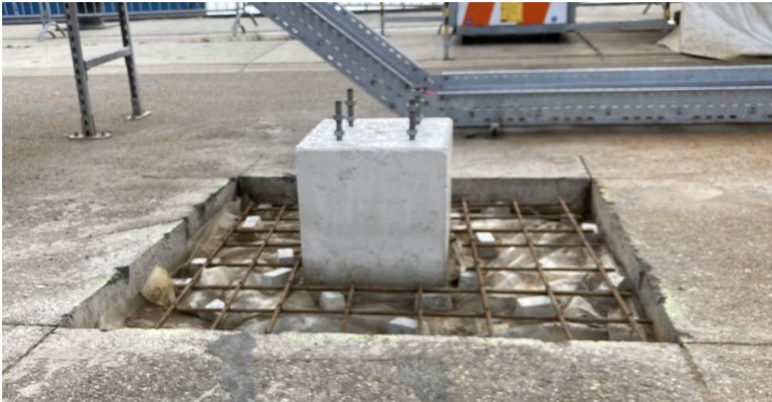
Figuur 8-4: Impressie aanvulling met vulbeton in de ruimte om de prefab poeren
