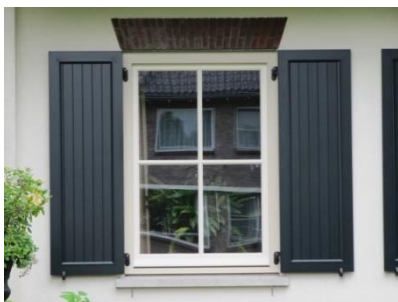
Niet-geperforeerde/niet geïsoleerde luiken
