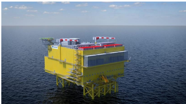
Figuur 3-1 Artist's impression van een 2 GW platform (met een stalen draagconstructie)
