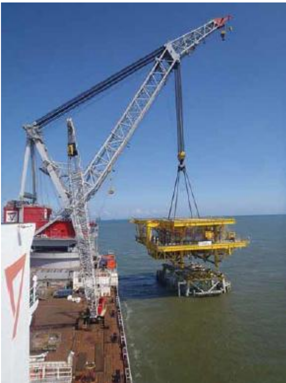
Figuur 3.3 Impressie plaatsing topside op jacket.
