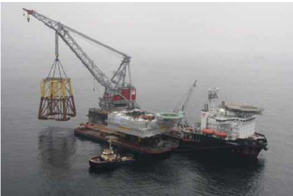
Figuur 3.2 Impressie plaatsing funderingen op locatie.
