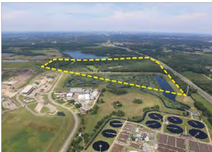
Figuur 2.9 Luchtfoto stationslocatie De Spinder
