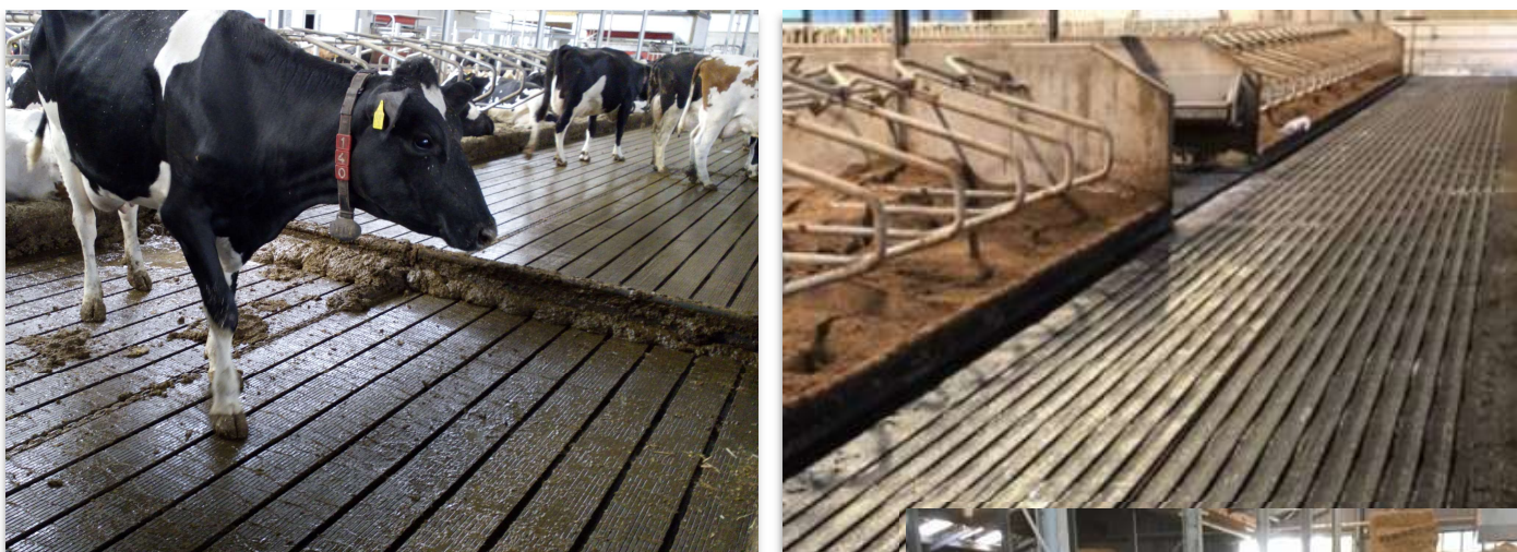
Figuur 9 Voorbeelden van vloeren voor primaire mestscheiding; linksboven G6-vloer (Swaans), rechtsboven V3-Groove vloer (V17 Agro) en rechts Zeraflex vloer.
