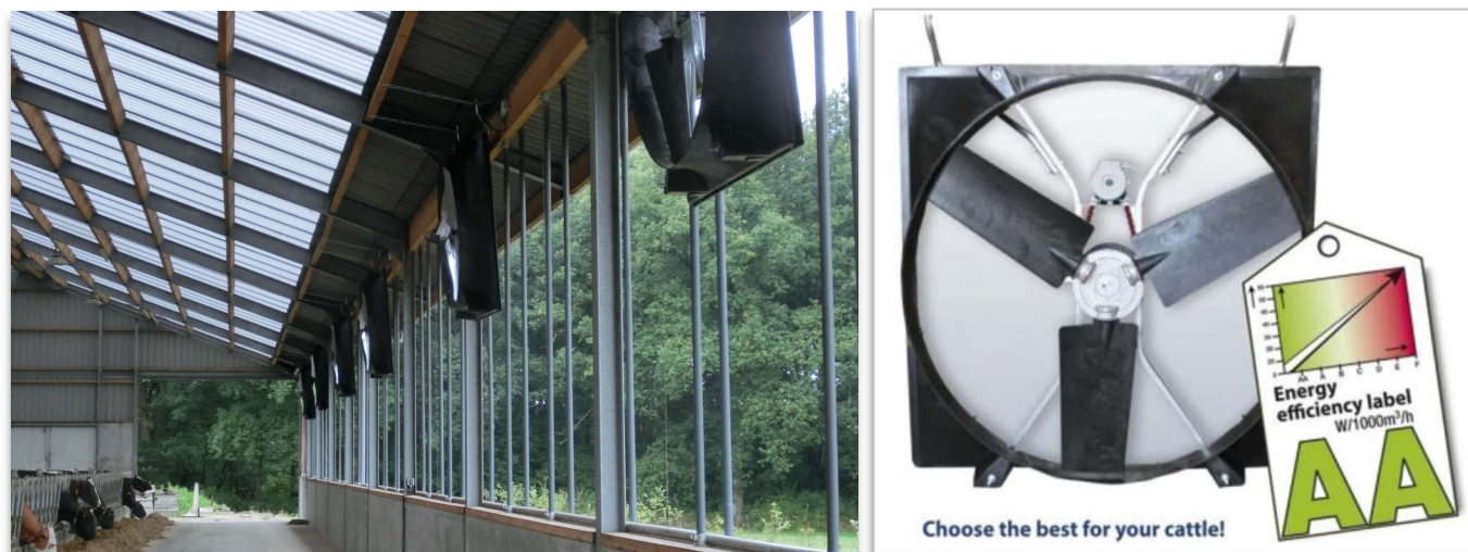
Figuur 8 Energiezuinige dwarsventilatoren (links) en ventilator met elektronisch geregelde gelijkstroom motor (rechts)
