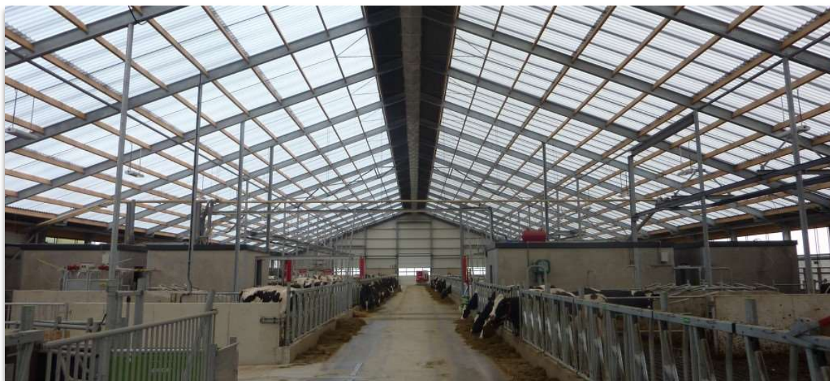
Figuur 2 Licht-doorlatende dakbedekking op de noordzijde van het staldak.
