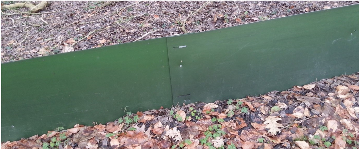
Foto 6.2: Voorbeeld van een standaard amfibieënscherm van het materiaal HDPE (© Foto: R.S.E.W. Leuven, 2017).
