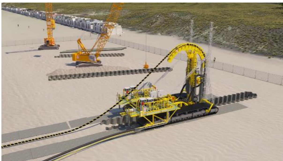
Figuur 3-2: Illustratie van begraafmachine (oud model) op strand met de kabel ingetrokken in de HDD
