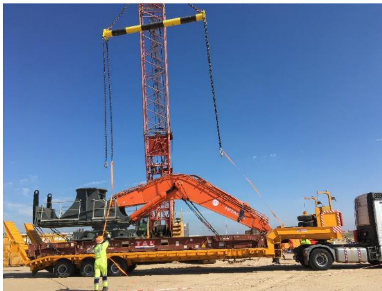
Figuur 5-6: Afladen van Starfish delen
