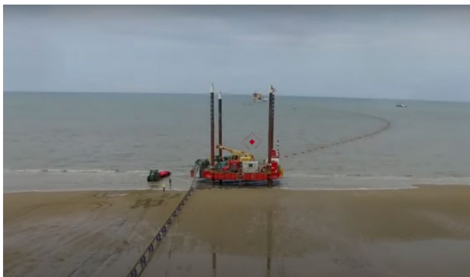
Figuur 4-9: Jack up ponton assisteert bij het positioneren van de kabel
