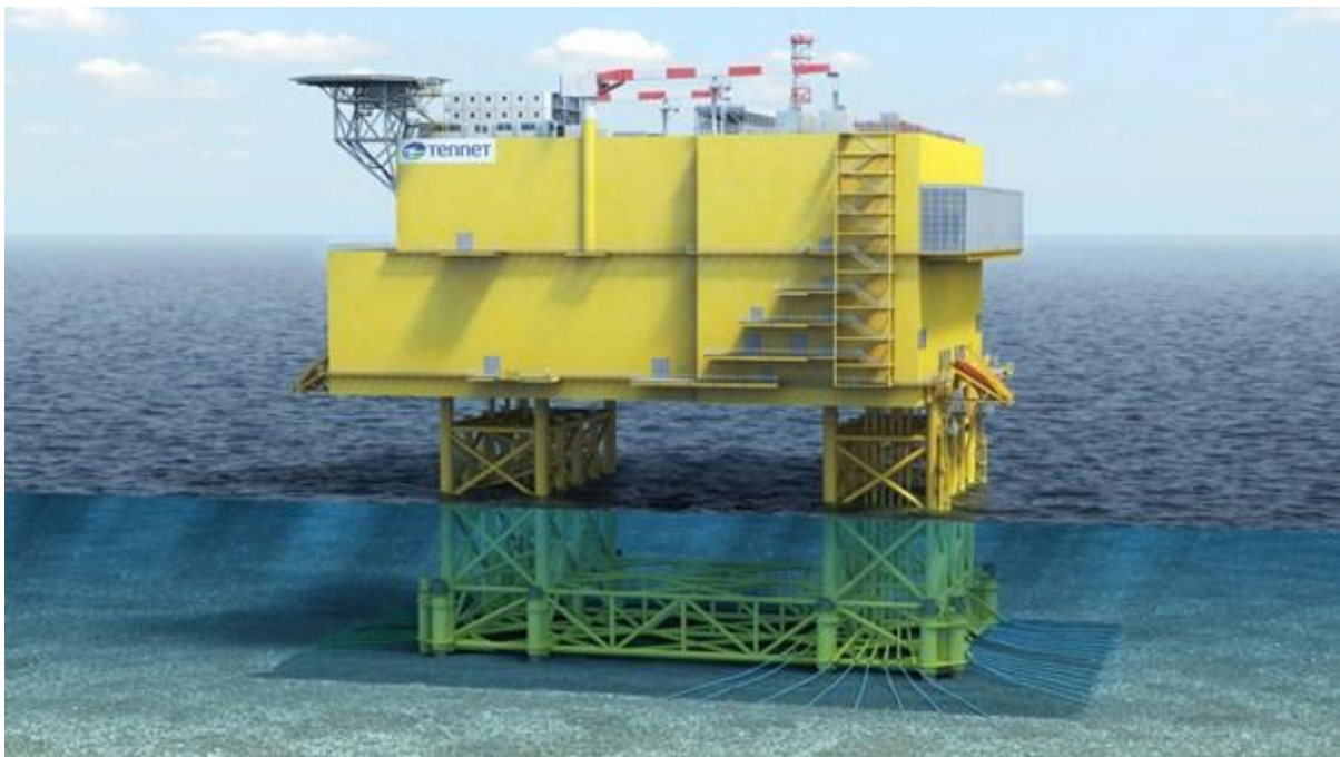
Figuur 2-3 Artist impression van het concept van 2 GW DC platform op zee
