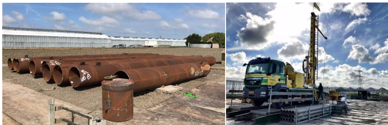
Figuur 5 Voorbereidingswerkzaamheden boorlocatie
