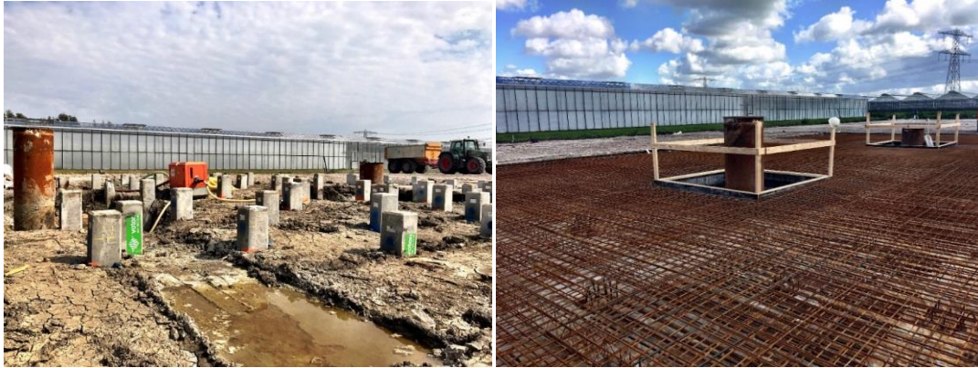
Figuur 7 Fundering boorlocatie
