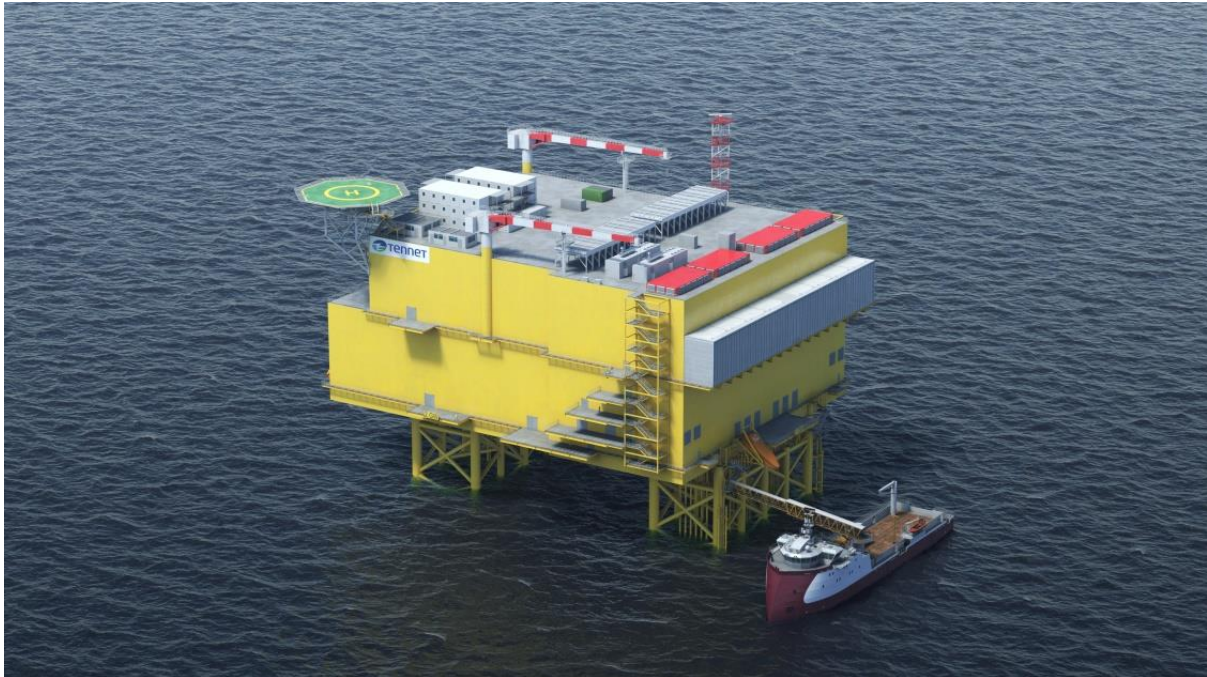
Figuur 6-4 Artist impression van een 2GW-platform op zee voor IJmuiden Ver Gamma
