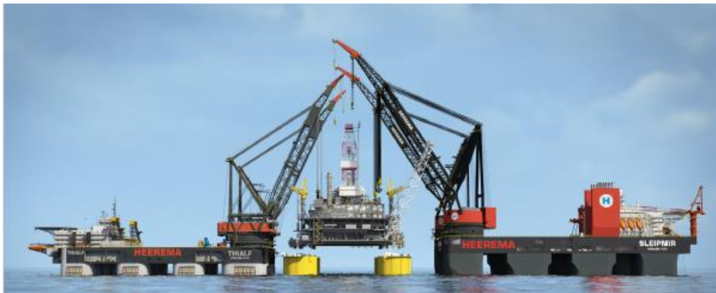
Figuur 1-6 Bovenbouw ophijsen met behulp van twee kraanschepen (hier: "Sleipnir" en "Thialf")
