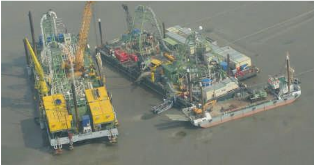
Figuur 1-11 Installatie in ondiepe zeegebieden (nearshore)
