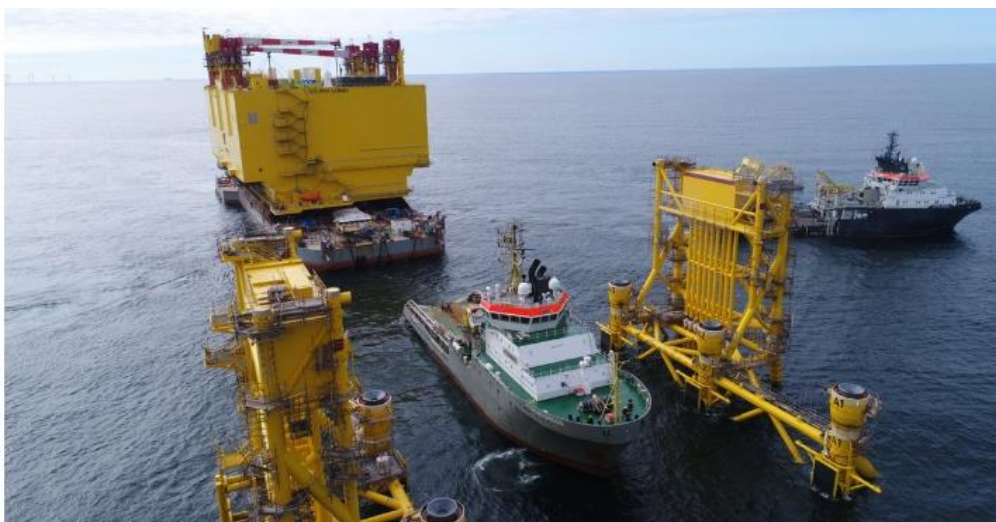
Figuur 1-7 Bovenbouw invaren en neerlaten door het transportschip te laten inzinken
