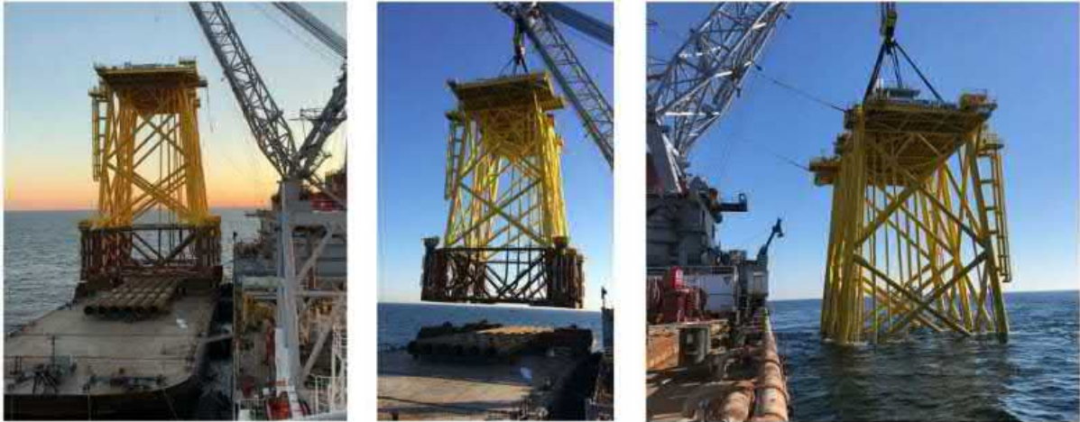
Figuur 10 Impressie van het plaatsen van een jacket
