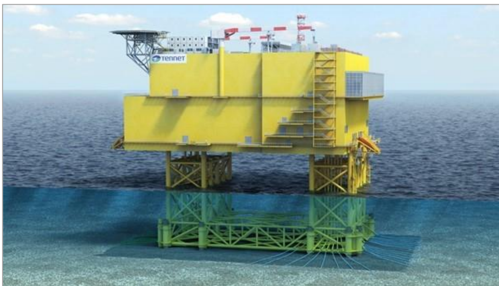
Figuur 2.2 Artist impression van het concept van 2 GW DC platform op zee
