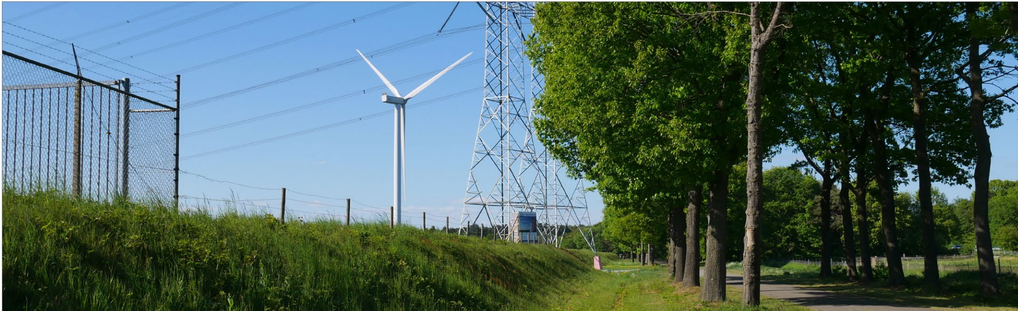
fig. 6 Links dijk van de RWZI met windturbine en de bestaande 380kV verbinding
