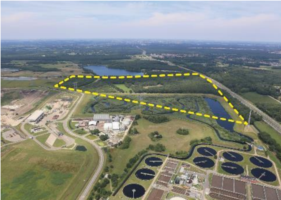
Figuur 2.9 Luchtfoto stationslocatie De Spinder
