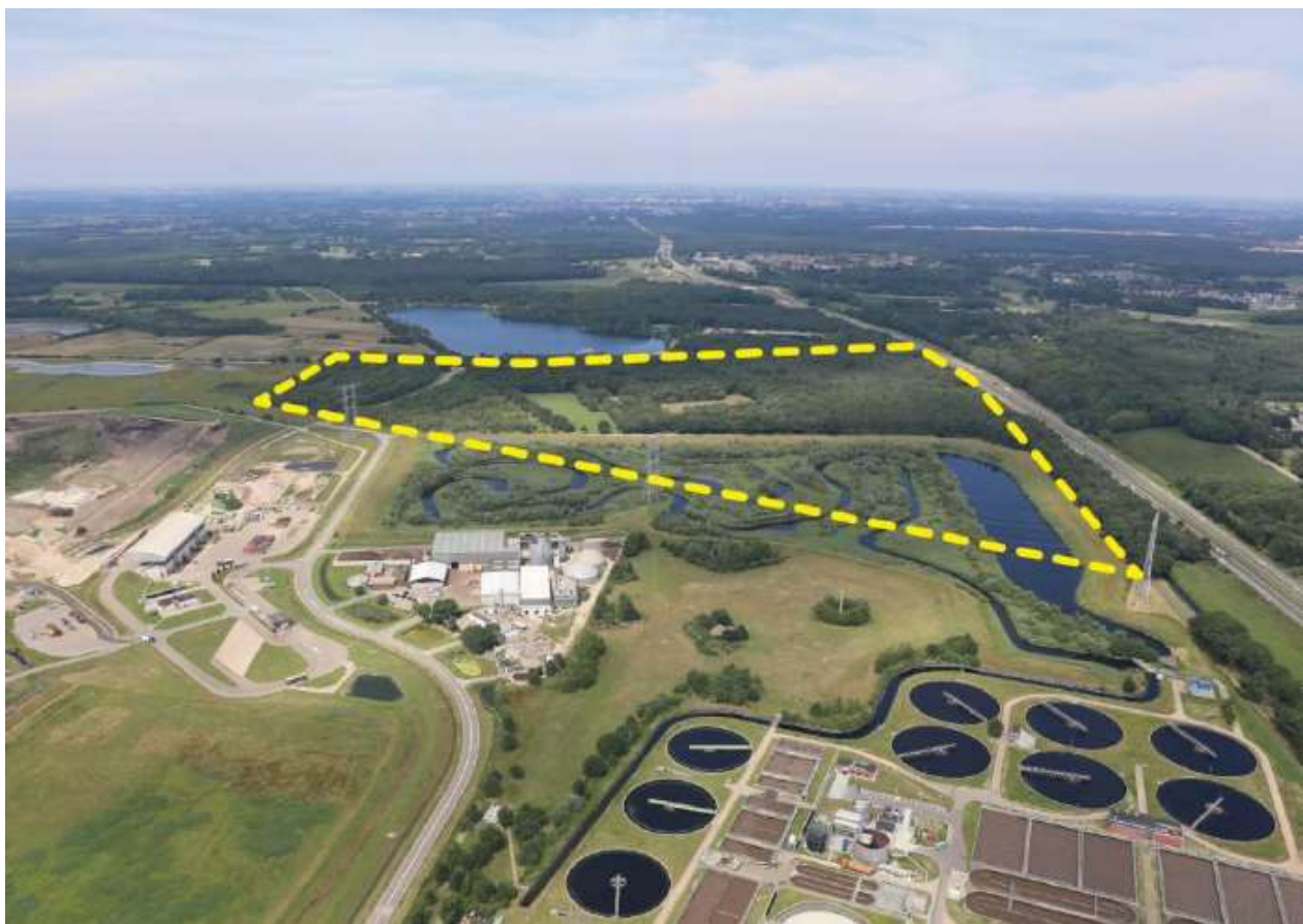
Figuur 6: luchtfoto hoogspanningsstation locatie de Spinder
