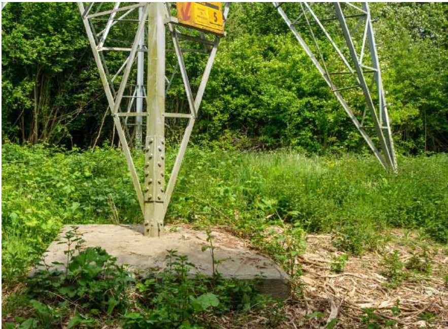
Figuur 3-11 Fundatie mast 5, de fundatie van mast 6 is op basis van luchtfoto's gelijk aan mast 5
