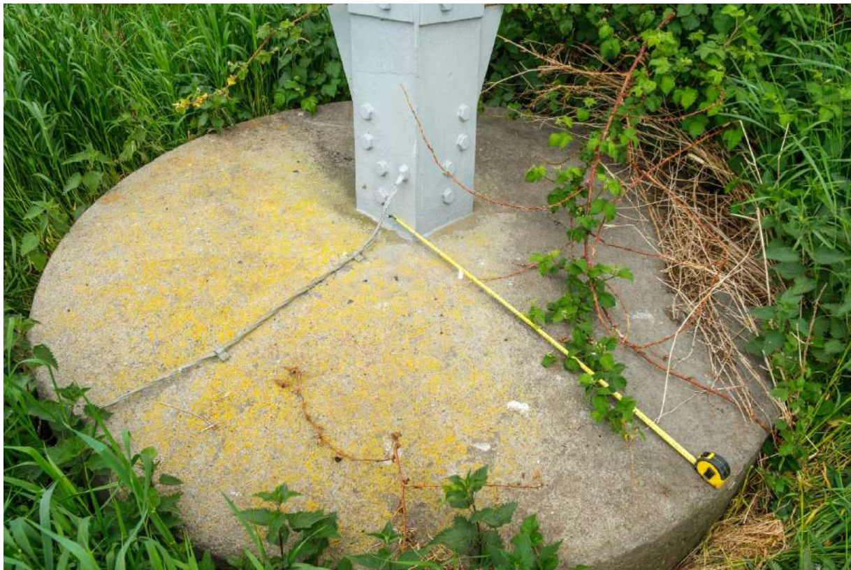
Figuur 3-10 Vierpaalspoer mast 82 met bovenafmeting 2,2 m
