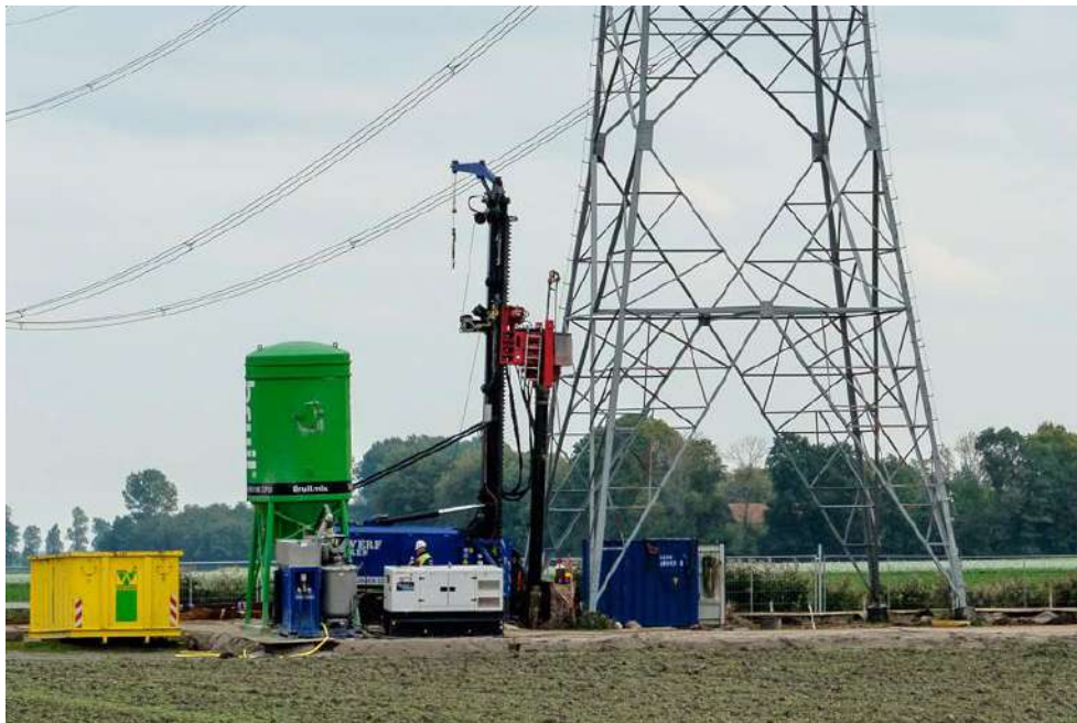
Figuur 6-3 Voorbeeld van boorstelling voor schroefinjectiepaal
