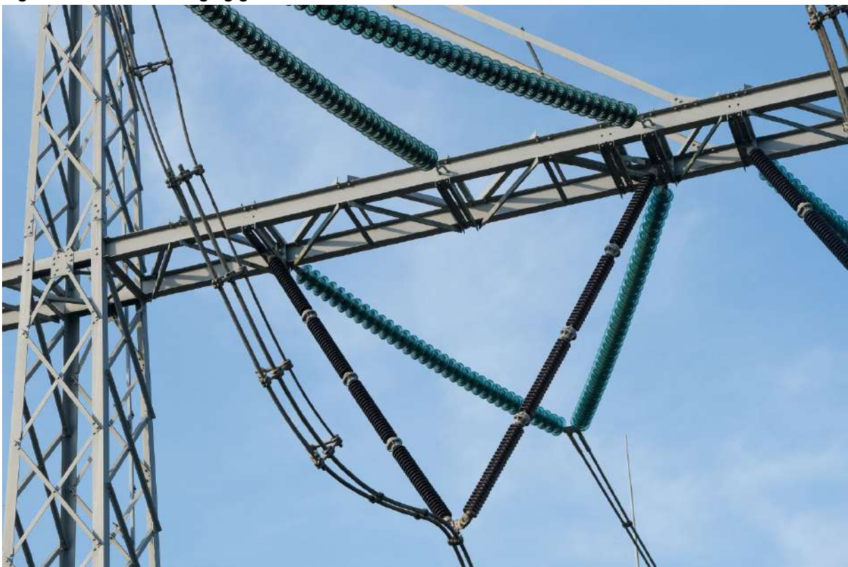
Figuur 14 Bestaande bevestiging van isolatorkettingen aan EHV-portaal aan te passen met platen en scharnieren
