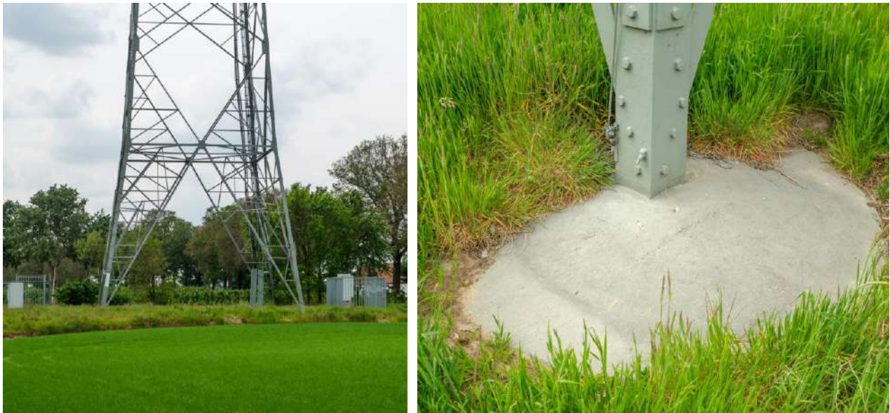
Figuur 3-5 Mast 17. De mast staat op een geheld terrein. De poerafmeting is bepaald op 1,8 m
