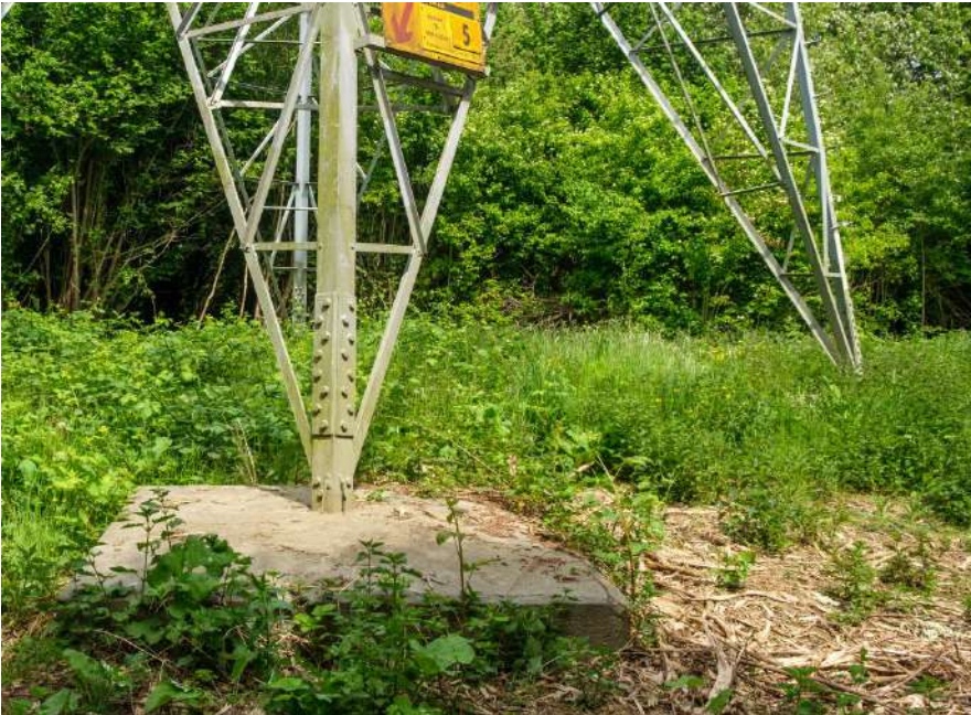
Figuur 3-11 Fundatie mast 5, de fundatie van mast 6 is op basis van luchtfoto's gelijk aan mast 5
