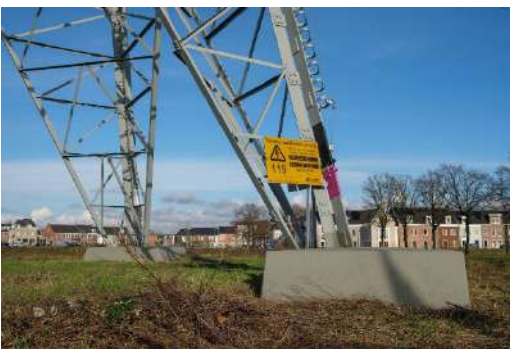
Figuur 6 Het onderste deel van het broekstuk is tijdens de reconstructie in de betonnen mastvoet gestort.
