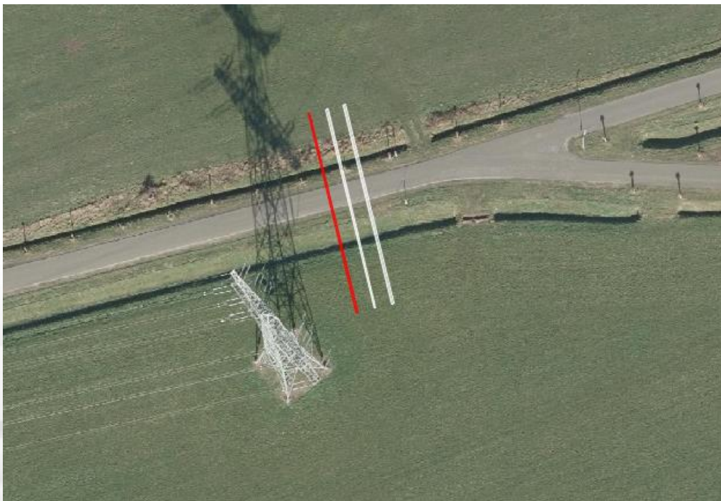
Figuur 1 overzicht werklocatie (Bron: Google Earth)
