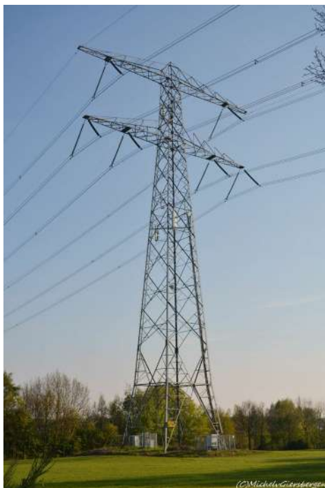
Figuur 3 Voorbeeld van opstelling ter plaatse van het onderstuk (mast 17)
