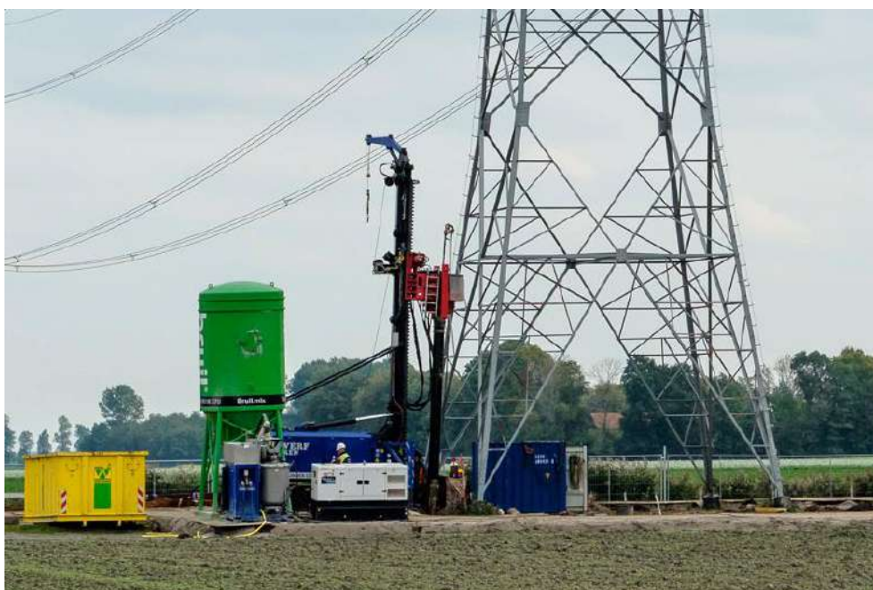
Figuur 6-2 Voorbeeld van boorstelling voor schroefinjectiepaal
