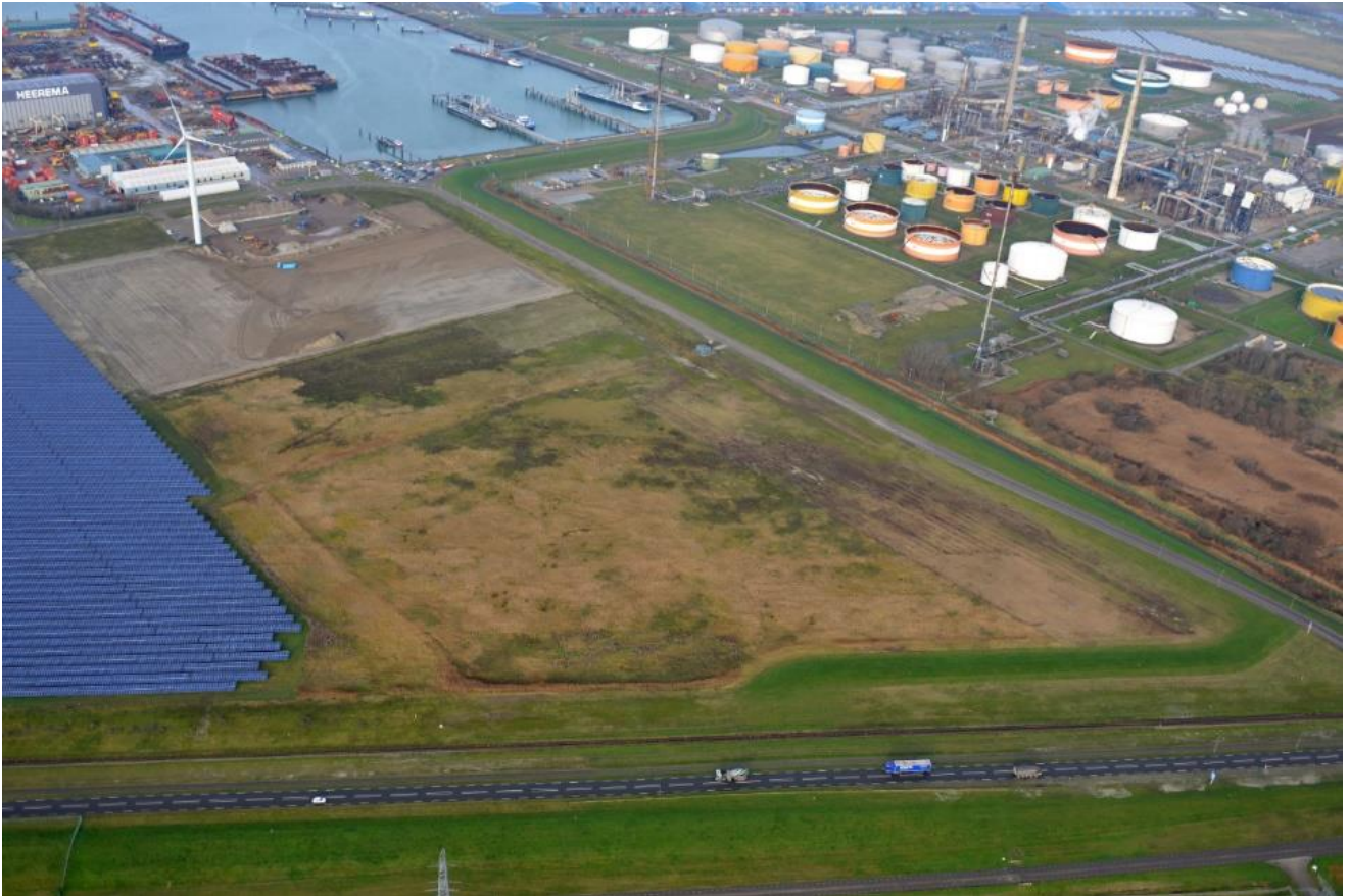
Figuur 4 Huidige situatie van de locatie voor het converterstation bij Borssele.
