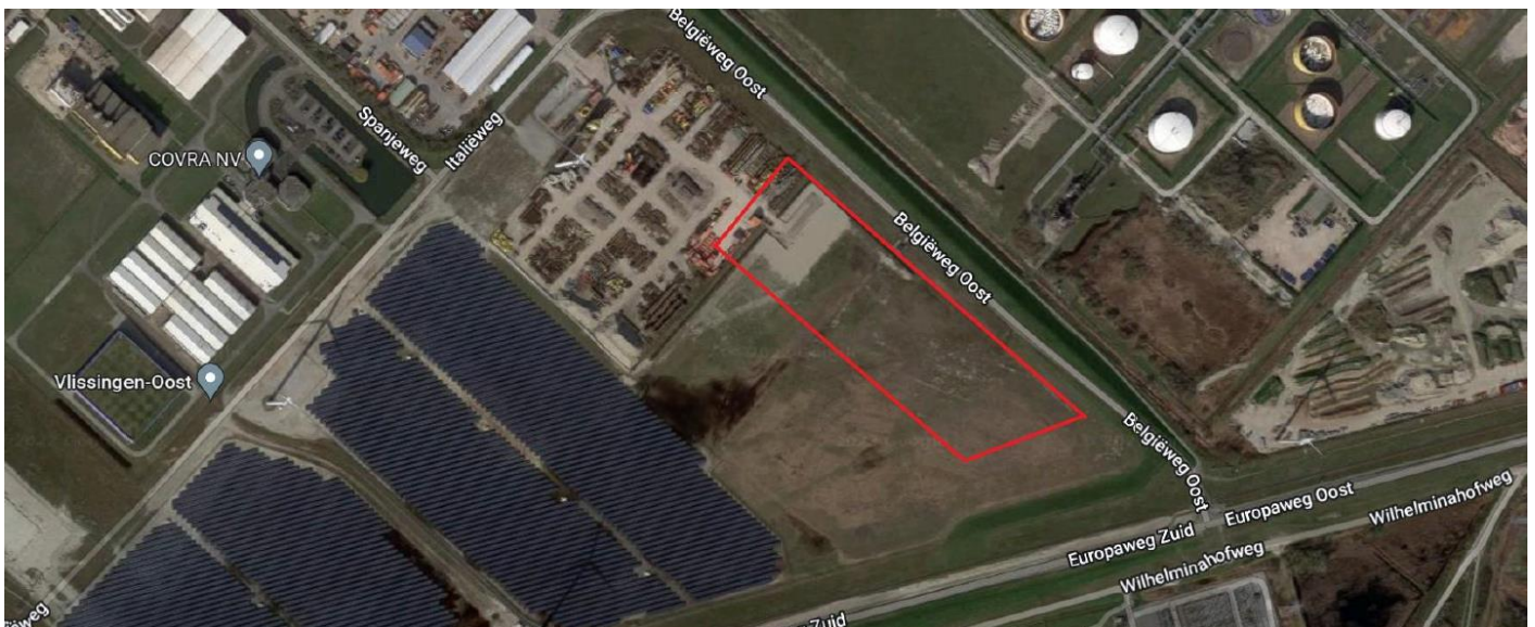
Figuur 1: situering converterstation Borssele
