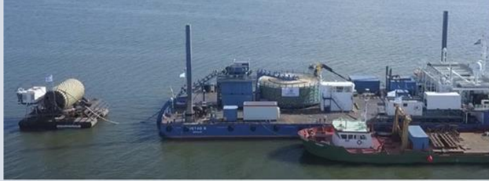
Abbildung 13: Beispiel Transport von Kabeln zur Baustelle im Watt
