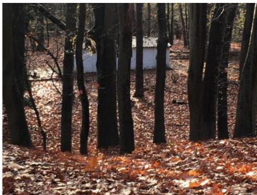
Figuur 14 Het huisje in het zuidelijke perceel
