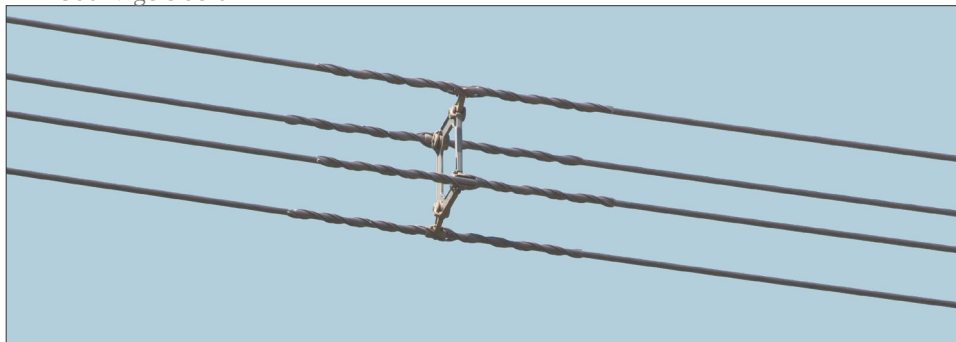
afb. 7 Afstandhouders gebruikt in de bundels van 380kV geleiders
